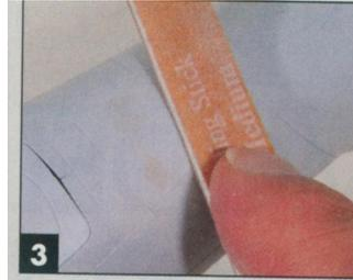
Es ist leicht zu schmirgeln. Bei jeder Anwendung dünn auftragen, damit es durchtrocknet. Wenn das Loch zu groß ist, dann eher mehrere dünne Schichten auftragen, als das Loch mit einem Mal zu füllen. So kann man sicher sein, dass alles getrocknet ist, wenn man schmirgelt.
